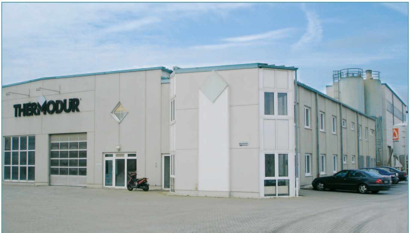
Produktionsgebäude THERMODUR Wandelemente in Kottenheim. Hier werden unsere Betonfertigteile hergestellt.
