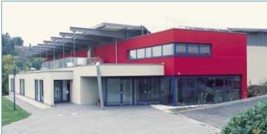
Die Sporthalle Puderbach: Nicht nur architektonisch ein hervorragendes Objekt. Durch die Verwendung von PINGER Wandelementen wurden alle Schallschutzvorgaben erfüllt.
