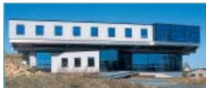
Verwaltungsgebäude Kaiser, Andernach
