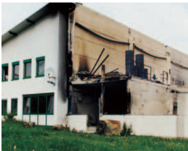
Een fatale brand vernielde de werkvloer. Dankzij de THERMODUR-brandmuur bleven de kantoren intact.
