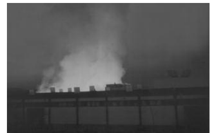
Großbrand bei der Fa. Wirtz, Mayen. Die THERMODUR Brandwand überstand zehn Stunden Dauerbrand.
